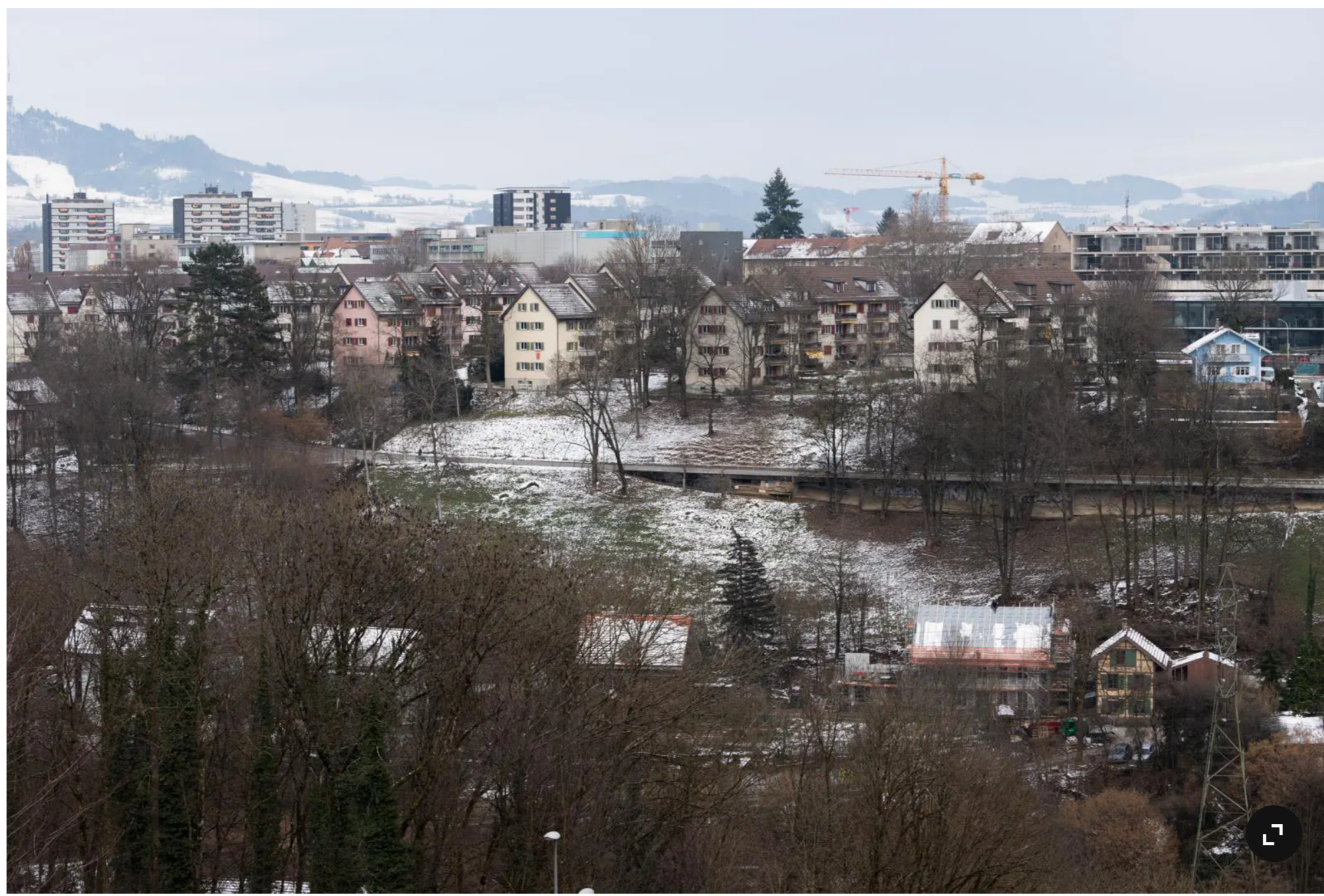
Auf Seite Länggasse käme die Brücke auf den Neufeldtunnel zu liegen. Hinten am rechten Bildrand ist wieder der SBB-Wylerpark zu sehen. Foto: Raphael Moser
